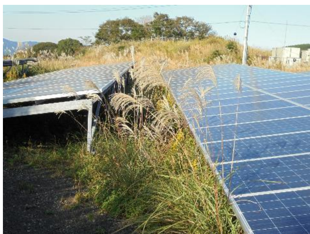
[雑草を放置するとその陰がパネルに落ち発電効率に影響を与える]
